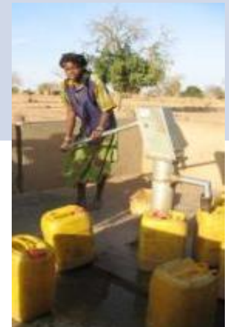
Forage équipée d'une PMH
